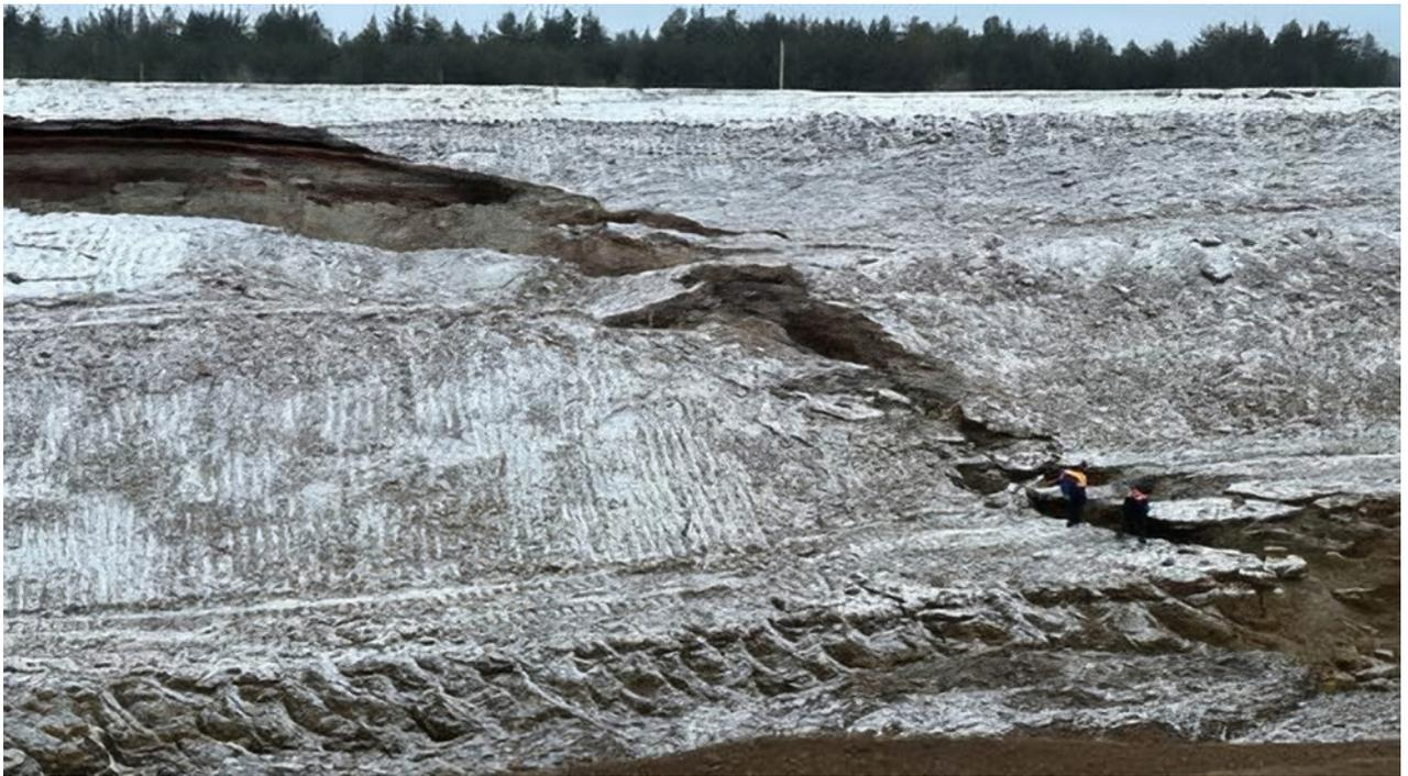
Фото 1. Образование трещин-заколов на 8 этапе строительства М-12
